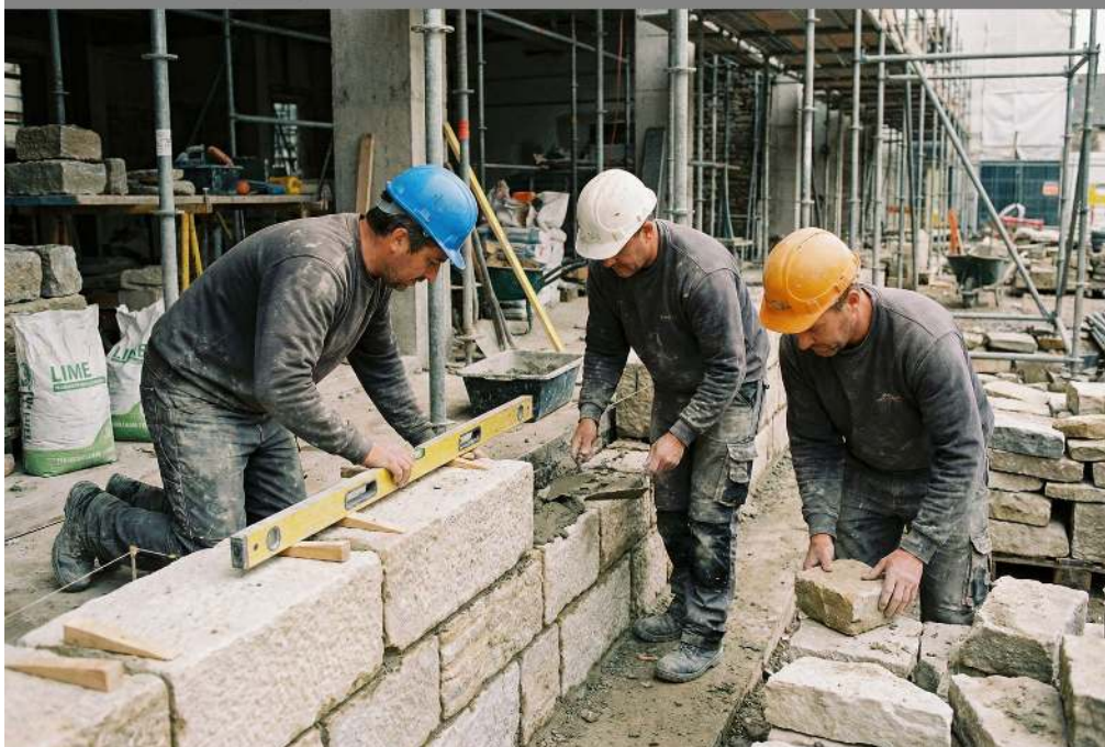
Pose de pierres avec contrôle de l'alignement, vérification continue des joints
